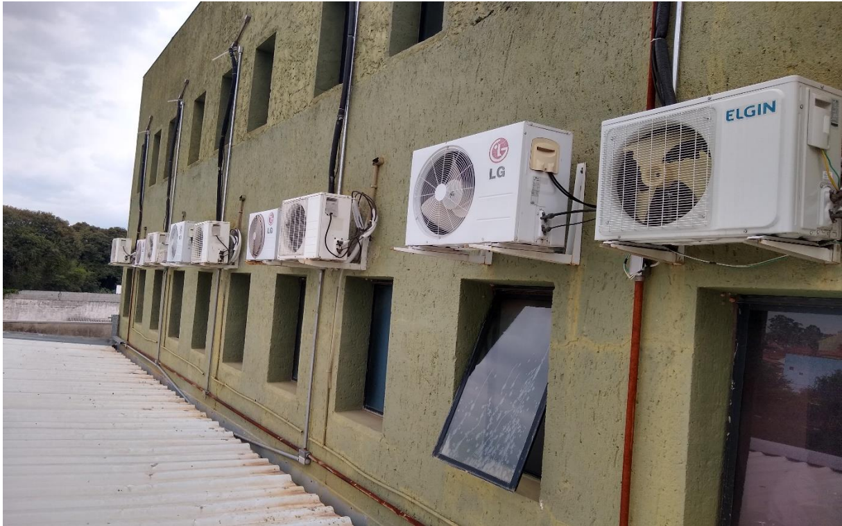
Telhado do legislativo
