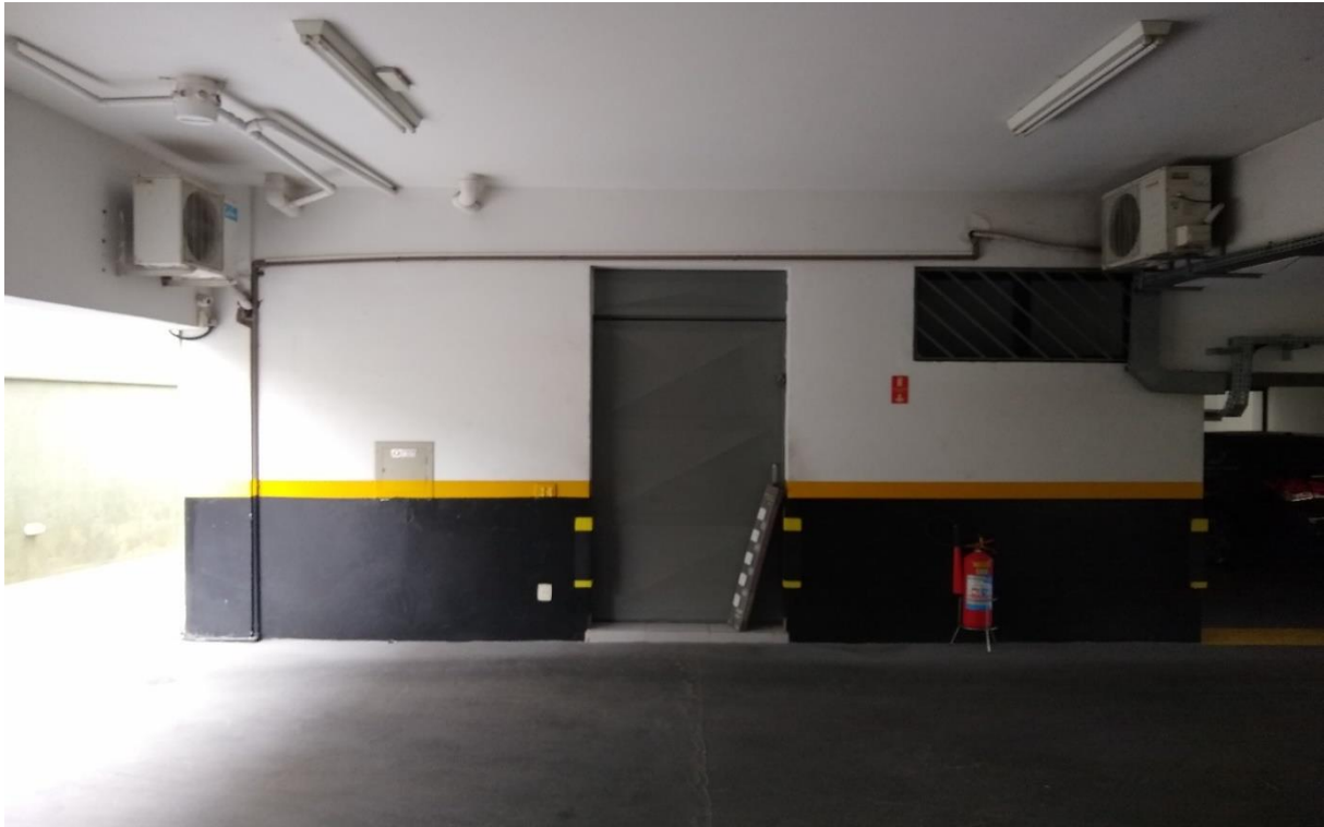
Estacionamento subsolo do prédio
