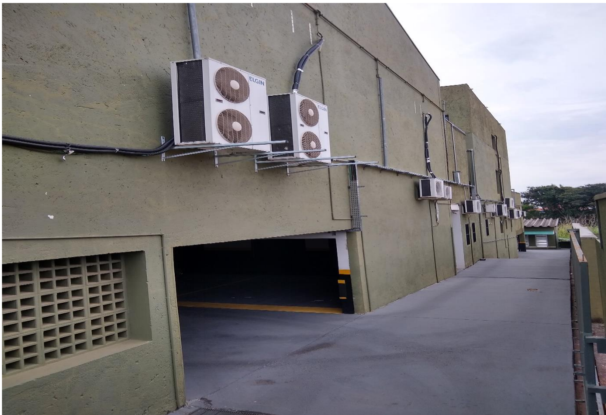
Início do corredor direito do prédio
