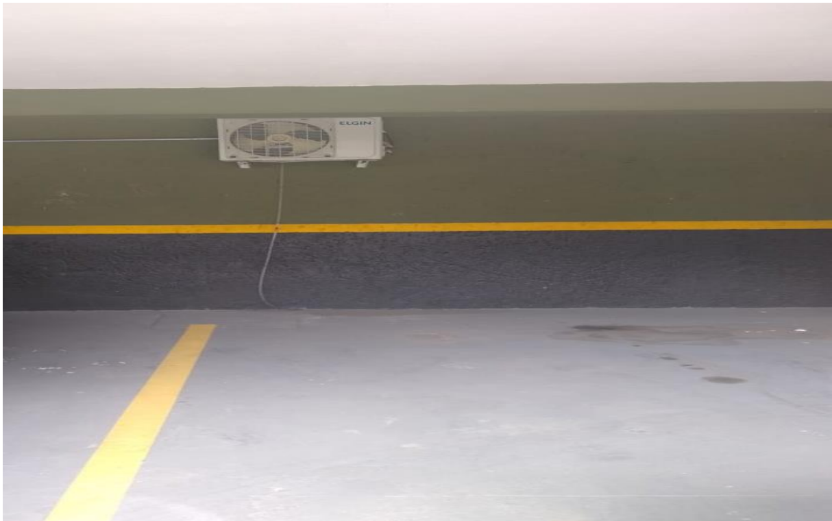
Estacionamento subsolo do prédio
