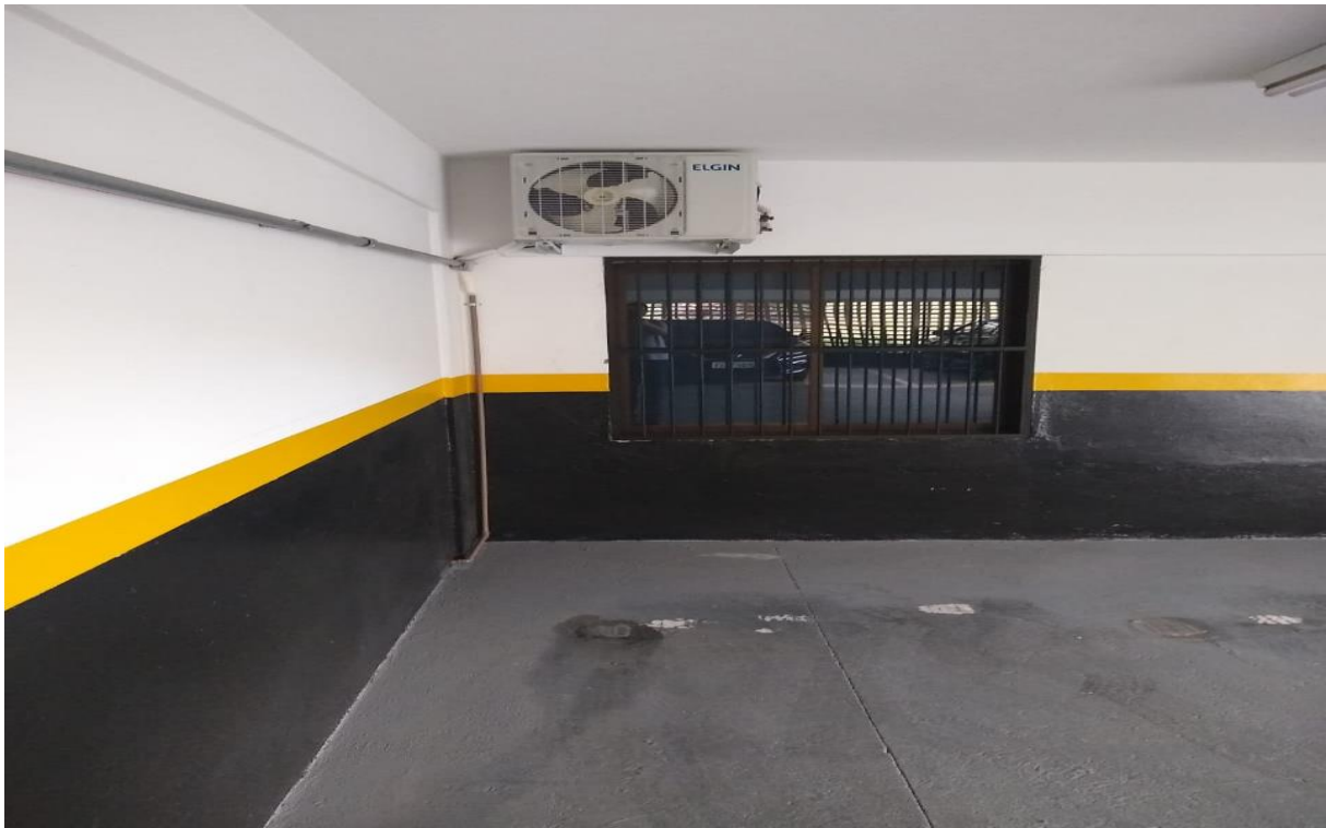
Estacionamento subsolo prédio
